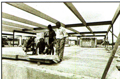
"71-bygningen" under opførelse - bygningen rummer i dag lokalene 27-29
